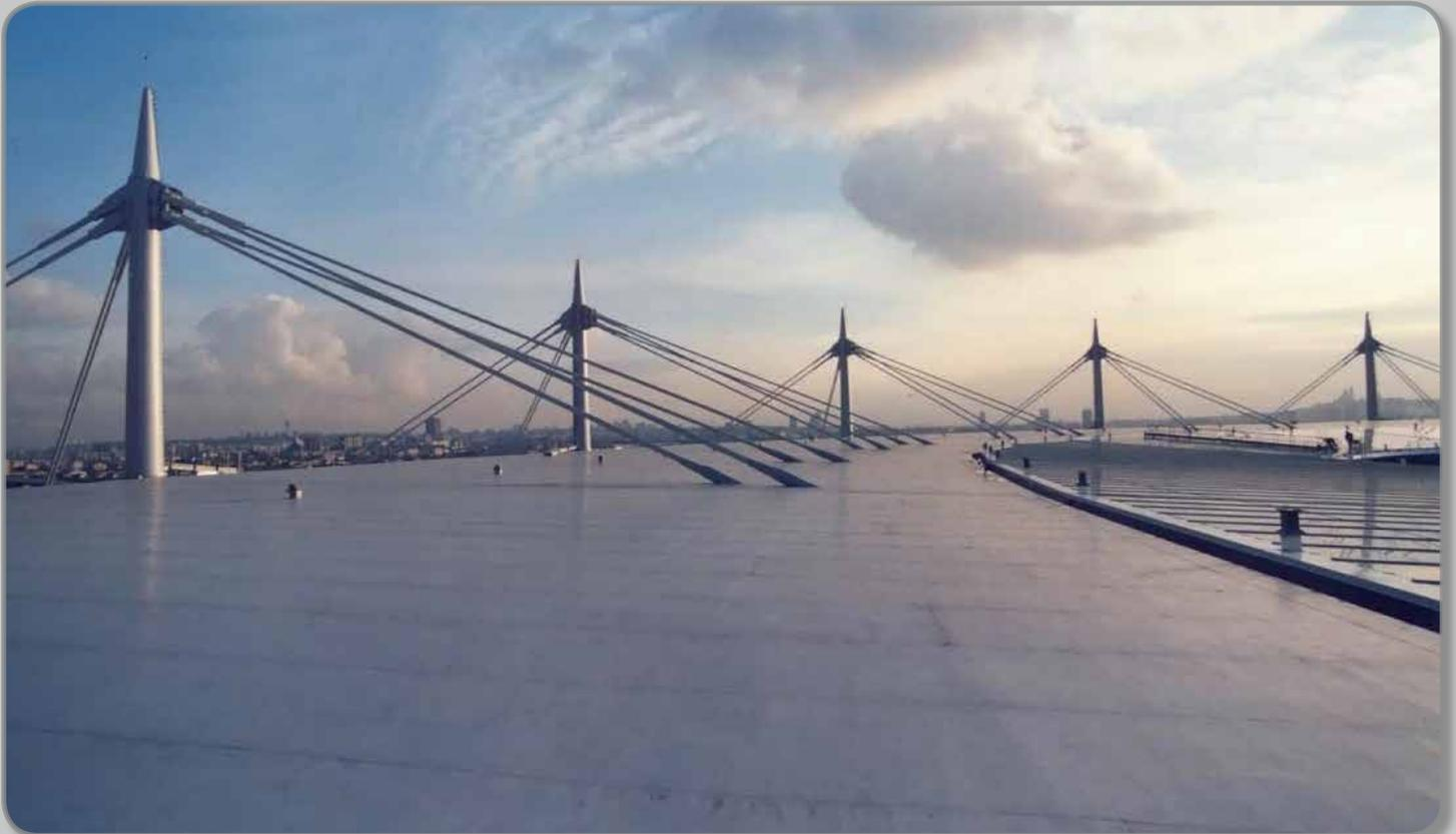
*Architecture : 18 pylônes soutenant la structure elliptique de la toiture, une charpente métallique de 4 m de haut et une couronne de 30.000 t de béton enchâssée dans le toit, le Rhenofol CV assure l'étanchéité de cette prouesse technique de 55 000 m<sup>2</sup> depuis 1997...*
