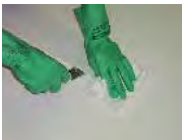
Soudure au solvant
