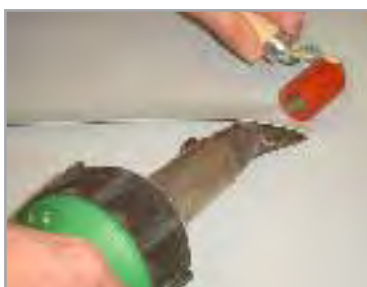
Soudure à air chaud manuel
